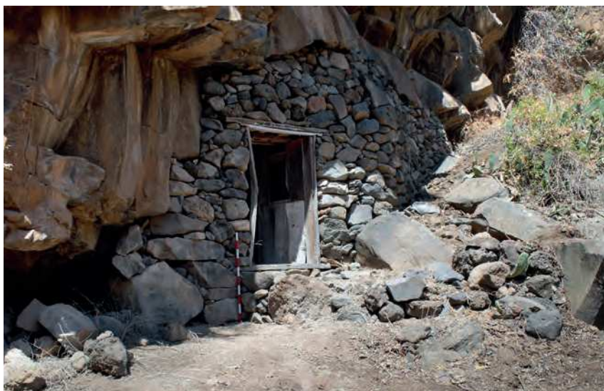
Muro de cerramiento y puerta en la Cueva de las Mejoras (2017)
